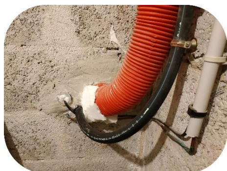
Conduit de sortie d'air du sous-sol (ancienne prise d'air)
