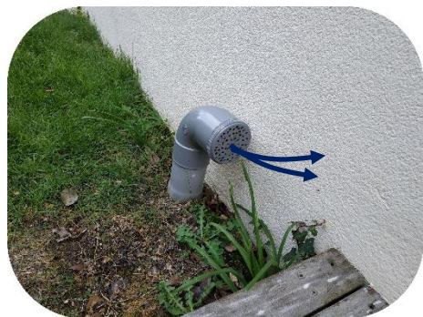
Conduit de sortie d'air du sous-sol (ancienne prise d'air)
